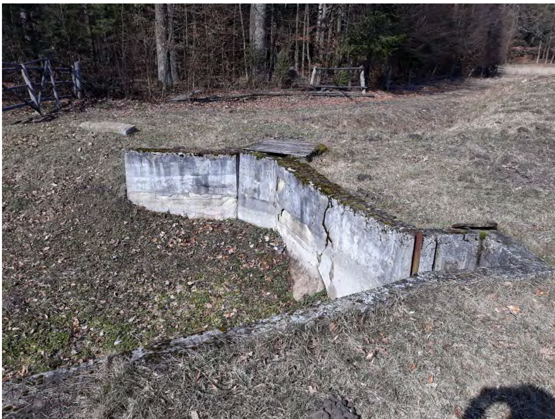
Zdjęcie nr 5: Końcówka kanału odprowadzającego wodę z płuczki – znacznie skorodowany beton ścian
