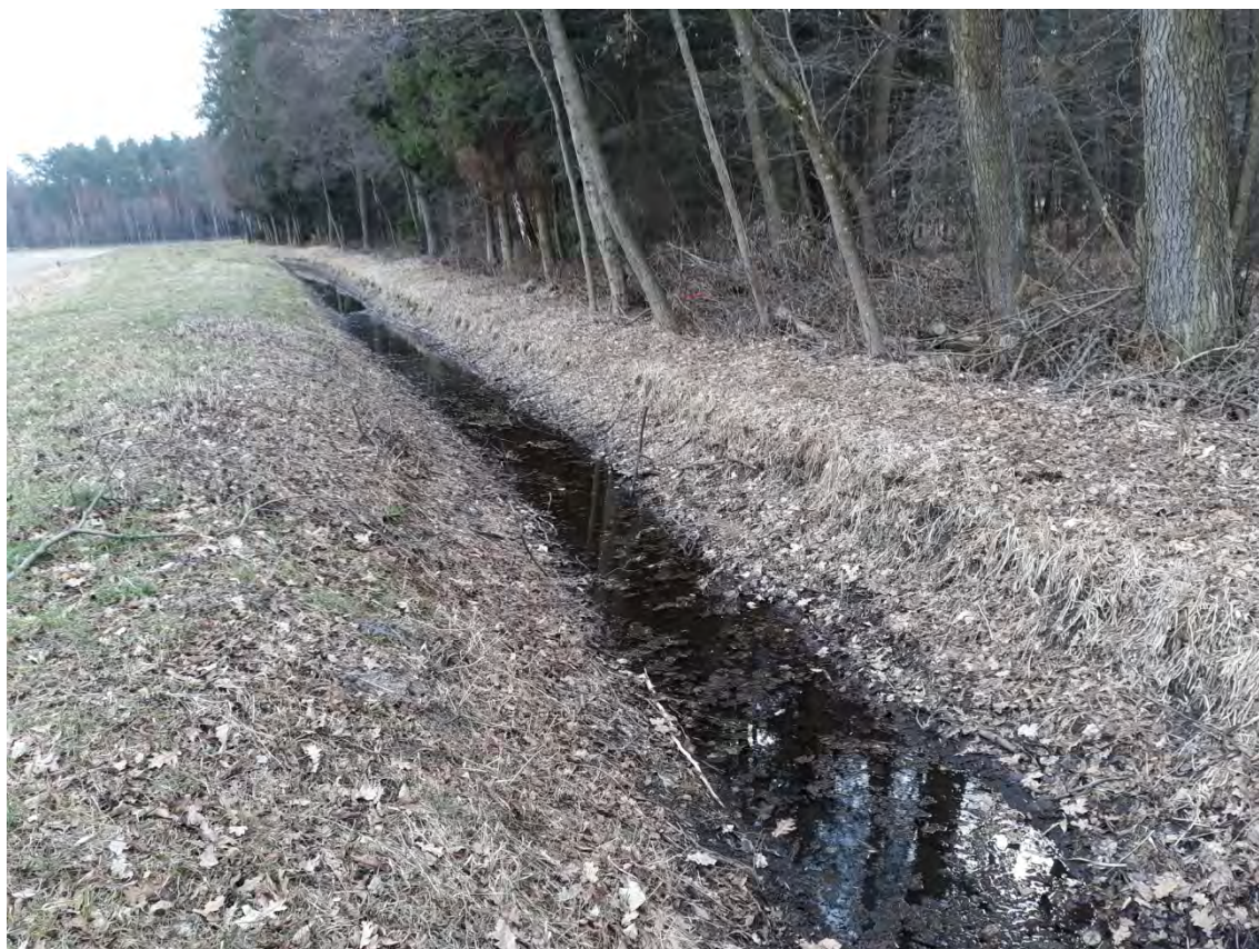
Zdjęcie nr 1: Doprowadzalnik (donośnik) „B”, widoczna erozja gruntu przy podstawie skarp
