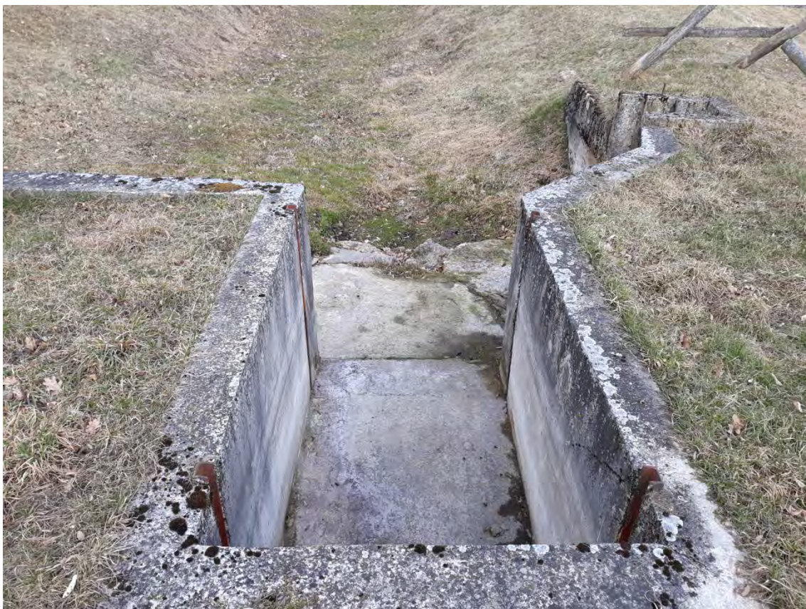
Zdjęcie nr 4: Wylot z płuczki - skorodowany beton ścian
