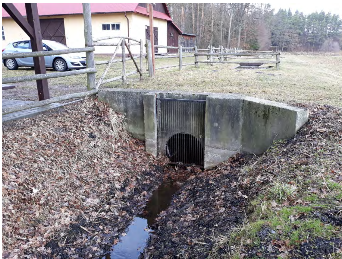
Zdjęcie nr 2: Wlot do płuczki- skorodowany beton ścian, korozja na kratce wlotowej
