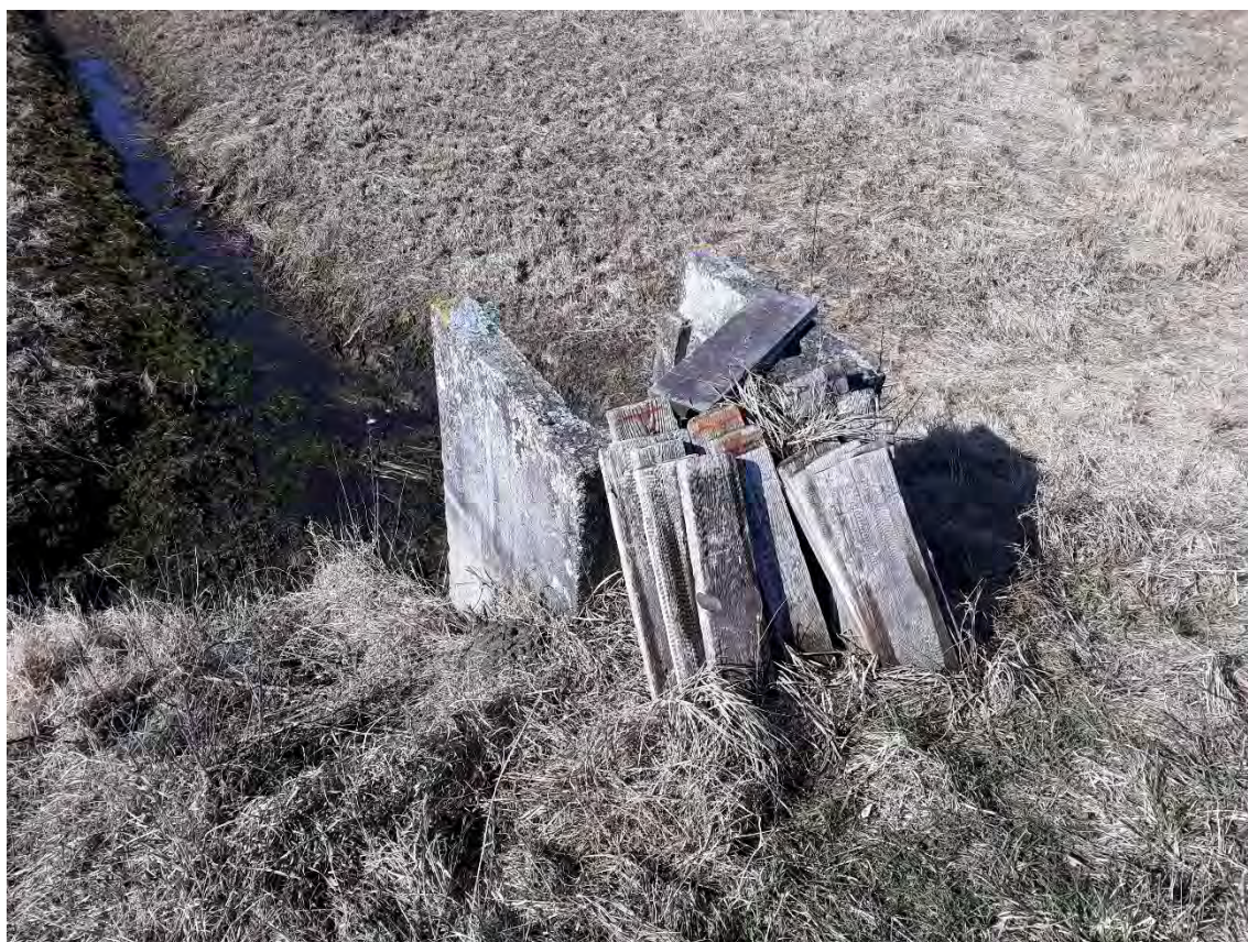
Zdjęcie nr 6: Znacznie zniszczony stojak mnicha stawowego
