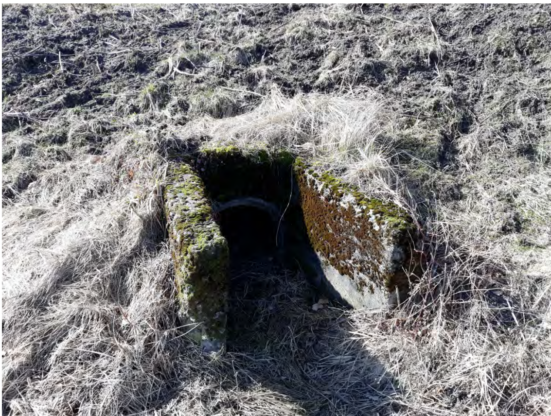
Zdjęcie nr 10: Zniszczony wylot z rurociągu mnicha stawowego
