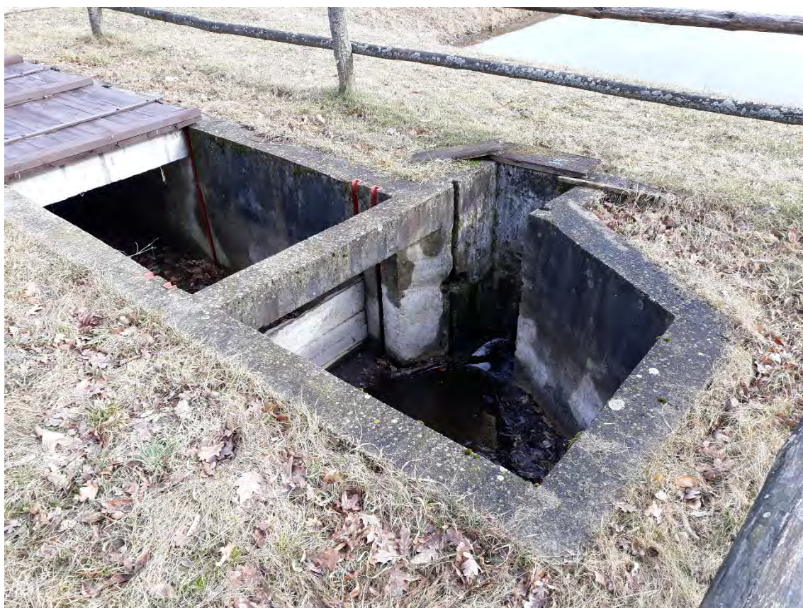
Zdjęcie nr 3: Płuczka - skorodowany beton ścian
